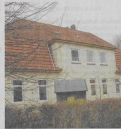
Die ehemalige Grundschule wird zu einem Stadtteil-Haus ausgebaut.
